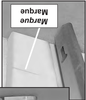
FIG. 4-1 Marque el marco de la puerta. Tracer les repères sur l'encadrement de la porte.
