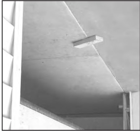
FIG. 6-6 2 x 4 debajo del centro del vano de la puerta. Colombe de 5 x 10 cm sous le centre de l'ouverture de la porte.
